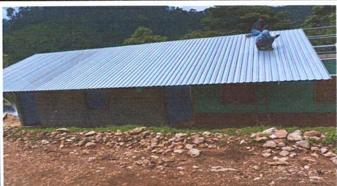
Foto1: se observa en la fotografia el cambio de techo de la escuela.
