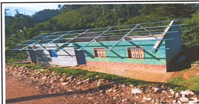
Foto 5: se observa en la fotografia el cambio de las costaneras y con su respectiva pintada.
